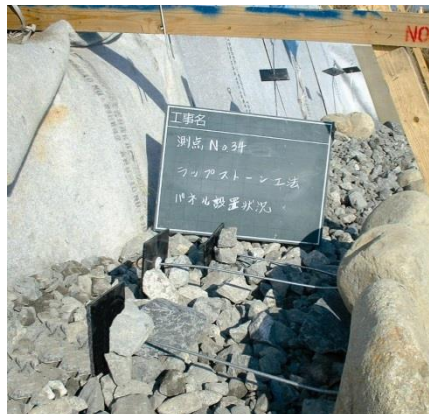
＜アンカー材、ストッパーパネル位置の確認写真例＞
