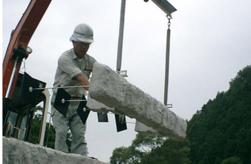
製品吊上げ状況
