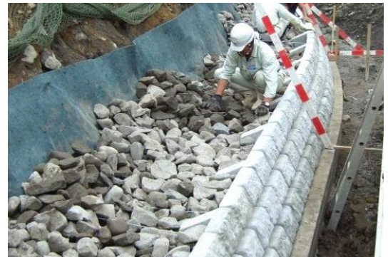
割栗石詰石状況（布積工）
