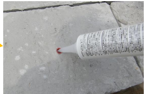
シリコン充填状況
