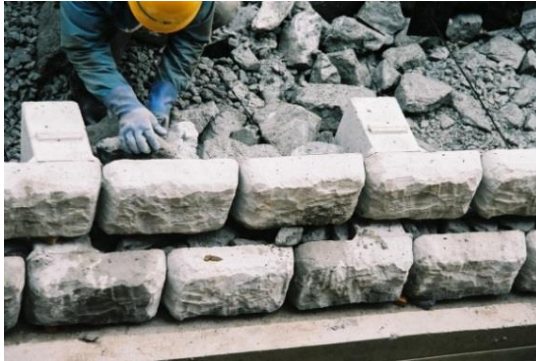
割栗石詰石状況（多段積工）
