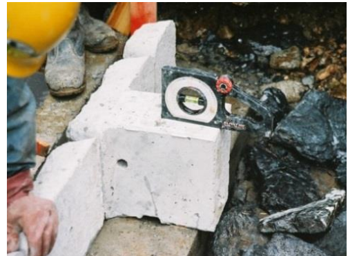
据付け位置・勾配調整状況
