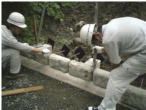
製品据付状況
