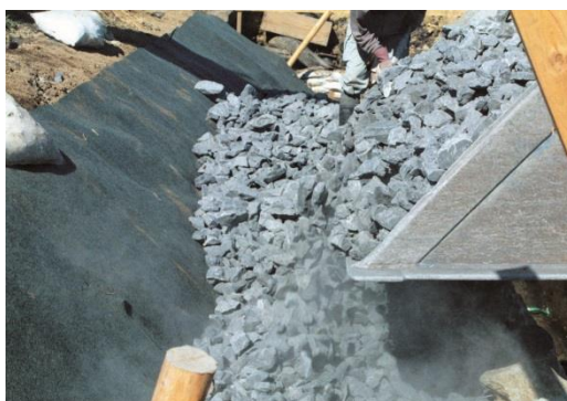
裏込材投入状況
