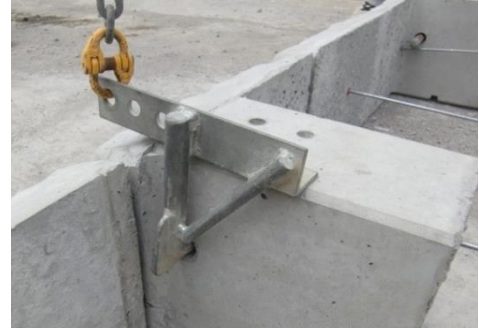
吊孔への吊冶具差込み状況
