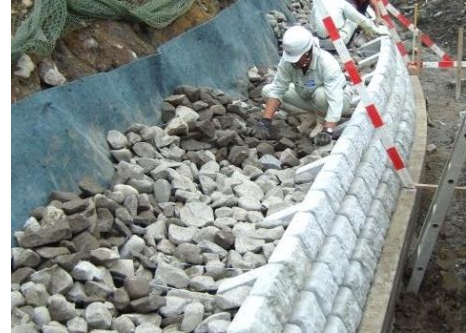
割栗石詰石状況（布積工）
