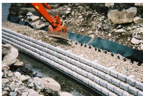
裏込材投入状況
