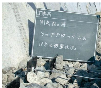
<アンカー材、ストッパーパネル位置の確認写真例>
