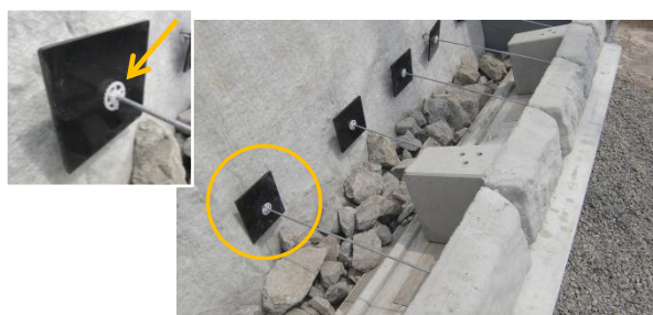
固定リング設置状況
