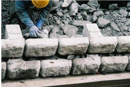
割栗石詰石状況（緑化積工）
