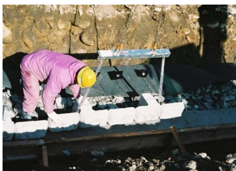
製品据付け状況
