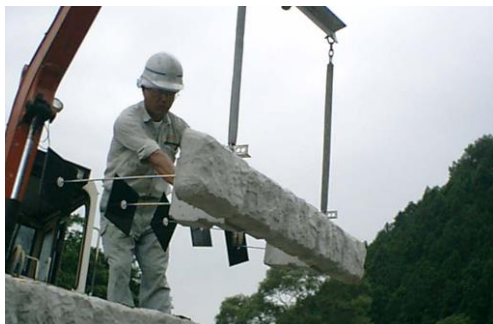
製品吊上げ状況
