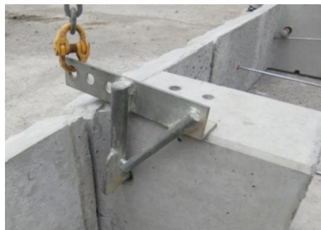
吊孔への吊冶具差込み状況
