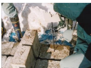
アンカー部材取付状況
