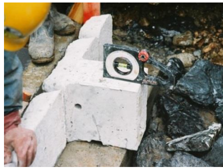
据付け位置・勾配調整状況
